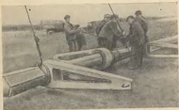
Рис. 20. Строповка железобетонной опоры.
